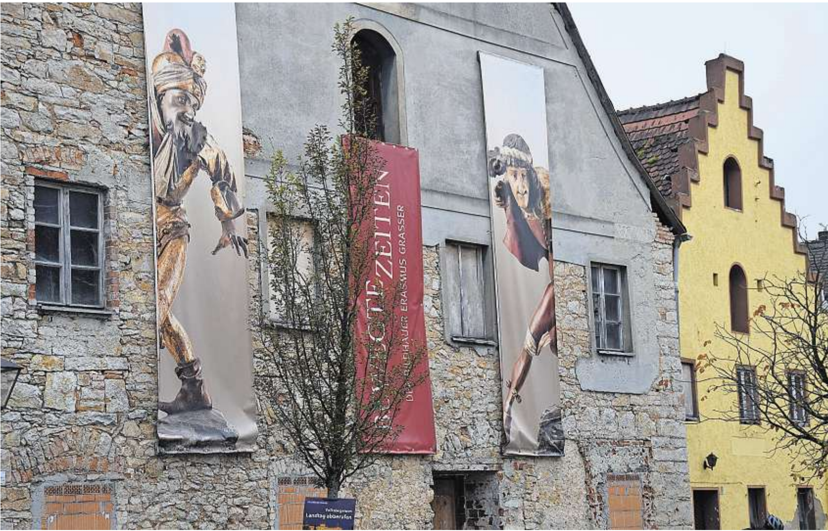
Der Markt Schmidmühlen will den Goldenen Anker am Marktplatz sanieren.
