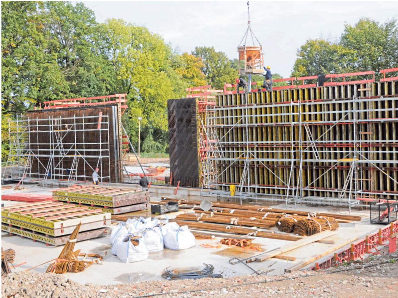
Unter Hochdruck wird in diesen Tagen auf dem Kläranlagengelände an der Siegfriedstraße gearbeitet, um das gute Wetter auszunutzen. Unser Foto zeigt die Arbeiten an den zwei riesigen Betonbecken, in denen künftig die biologische Reinigung der Abwässer stattfinden wird.
