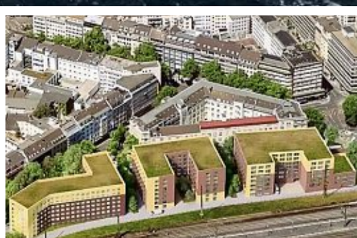
Auf der Hartort-Straße am Hauptbahnhof werden gleich drei Hotels nebeneinander gebaut – mit zusammen 700 Zimmern.
