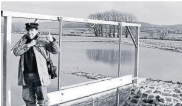
Daumen hoch für ein gelungenes Projekt: Helmut Merz an dem Bohlenwehr, mit dem ein Flutgraben aufgestaut wird, der somit für die entsprechende Auenvernässung sorgt.
