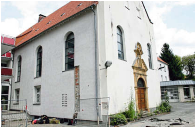
So sah die Kapelle bis zur kompletten Umgestaltung aus. Das Eingangsportal ist heute das Tor in die Firmenzentrale.
