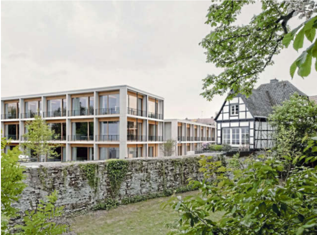
Der Blick auf die Jacoby Studios aus Richtung Spitalmauer zeigt den Neubaufügel im städtebaulichen Kontext.
