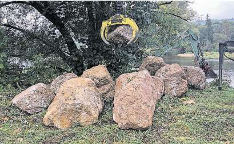
Am Wehr in Ramspau ist der Bagger im Einsatz, um Störsteine ins Wasser zu setzen. Sie sollen künftig helfen, Laichplätze für selten gewordene Fischarten zu schaffen.
