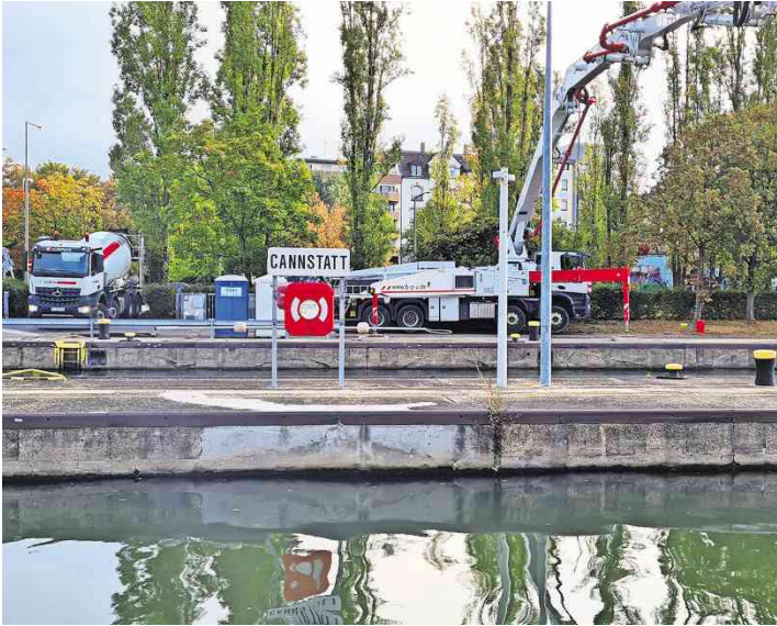
Weite Wege erschwerten die Arbeit: Der Beton musste in Rohren über die Schleuse gepumpt werden.
