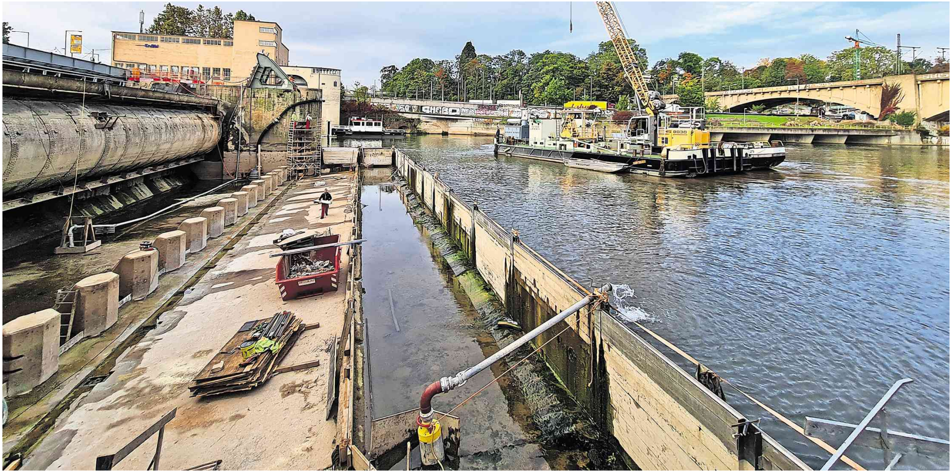
Per Schwimmkran werden die Betonkübel zum Wehr gebracht. Mit dem Baumaterial werden die Stahlköcher im Boden und die Seitenlager im Pfeiler – im Bild zu sehen – dauerhaft fixiert.
