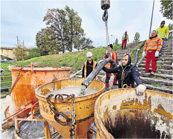
Auf der Neckarinsel wird der Beton in Kübel gepumpt. Den Arbeitern bleiben rund 30 Minuten Zeit, um das Material zu verarbeiten.
