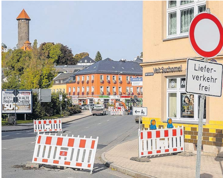
Die Fahrbahn der Breitscheidstraße zwischen Lauckners Kreuzung und Hainstraße wird erneuert. Außerdem entsteht ein Stück vor dem Eiscafé Venezia (Bildmitte) eine Verkehrsinsel. Der Liefer- und Linienverkehr läuft über die Hainstraße und wird per Ampel geregelt.
