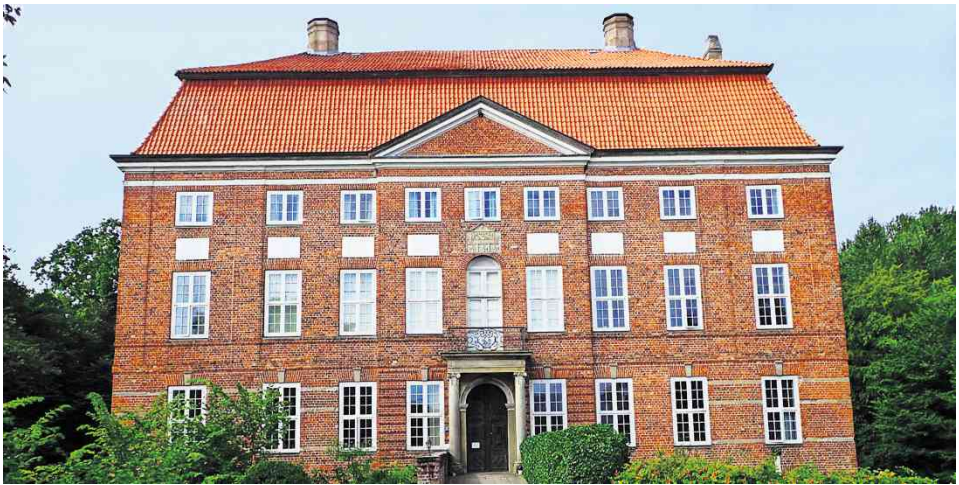
Auf den Grundmauern einer ehemaligen Wasserburg ließ der Namensgeber von Gut Ludwigsburg ein repräsentatives Herrenhaus errichten.
