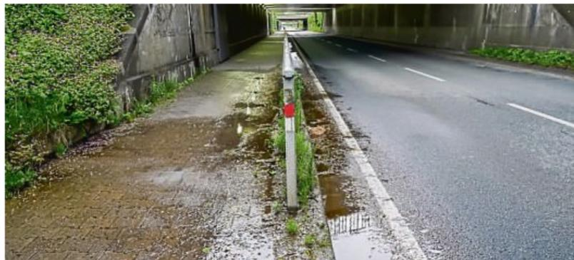
**Ein Dauer-Problem:** Durch Wasser, das aus dem Bahndamm tritt, steht der Geh- und Radweg unter den sieben Brücken regelmäßig unter Wasser.
