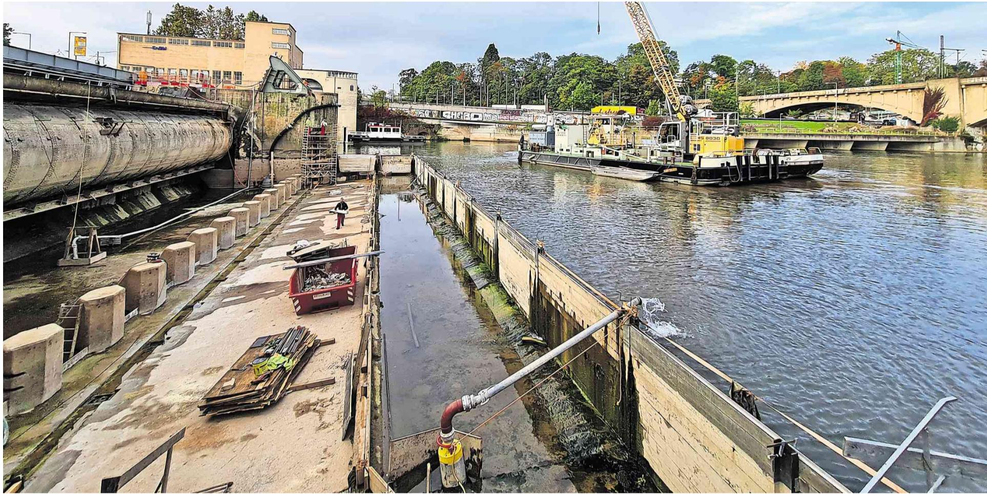
Per Schwimmkran werden die Betonkübel zum Wehr gebracht. Mit dem Baumaterial werden die Stahlköcher im Boden und die Seitenlager – im Bild zu sehen – dauerhaft fixiert.
