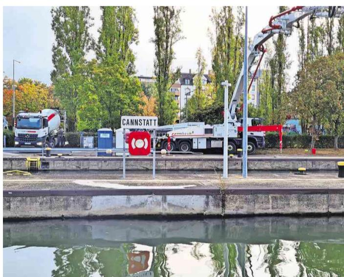
Weite Wege erschweren die Arbeit: Der Beton musste in Röhren über die Schleuse gepumpt werden.
