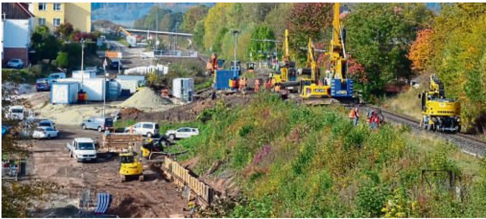
Großeinsatz: Seit der Freigabe der fußläufigen Verbindung zwischen dem Bahnhaltepunkt und der Siedlung Rothenberg (hinten) wird der Abbruch des Bahnübergangs von 1905 an der Schlarper Straße (vorn) vorbereitet. Die Bahnlinie (rechts) ist gesperrt.
