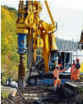
Bohrlöcher für Stützfundamente: Arbeiten auf der alten Bahnbrücke an der Schlarper Straße.
