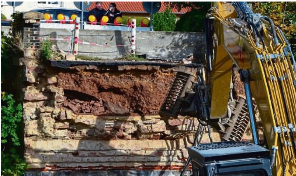
Abbruchkante: Auch diese Fundamente der ehemaligen Brücke zur Schlesierstraße hin werden noch abgerissen. Übrig bleibt eine Böschung zu den Gleisen.
