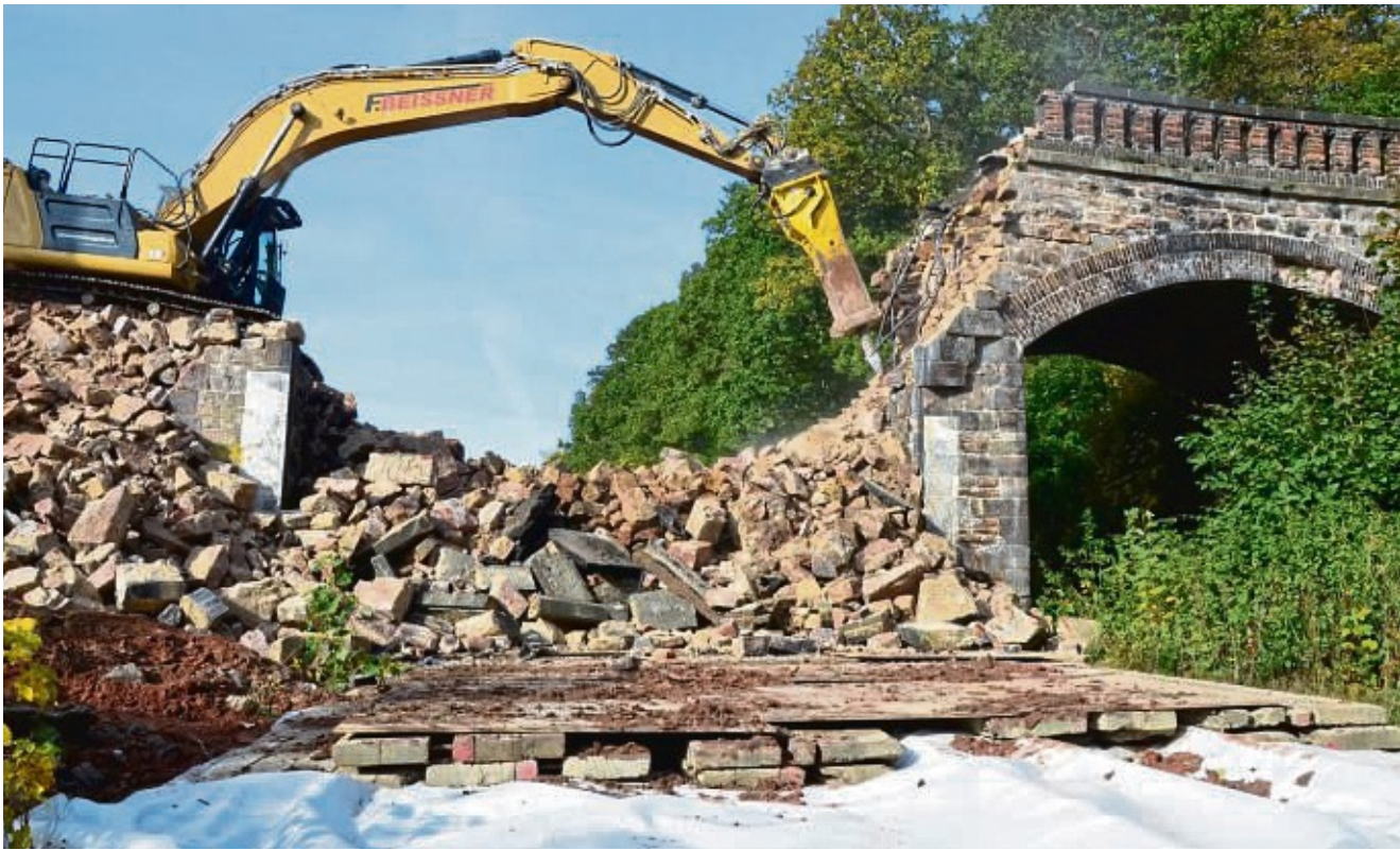
Brückenbauwerk nach wenigen Stunden Geschichte: Die um 1875 gebaute Brücke zwischen der Schlesier Straße und dem Schlarper Weg über der Bahnlinie Uslar-Northeim gibt es nicht mehr. Am Montagmorgen begannen Bauarbeiter eines Spezialunternehmens mit dem Abbruch. Das Gleisbett wurde abgedeckt.
