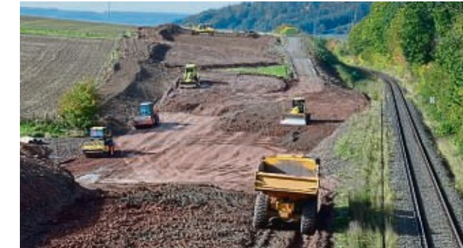
Vorbereitungen im Baufeld: Raupen, Bagger und Speziallastwagen bewegen zwischen Volpriehausen und Gierswalde Erdmassen in dem Areal, wo einst die neue Bundesstraße 241 parallel zur Bahnlinie verlaufen soll.
