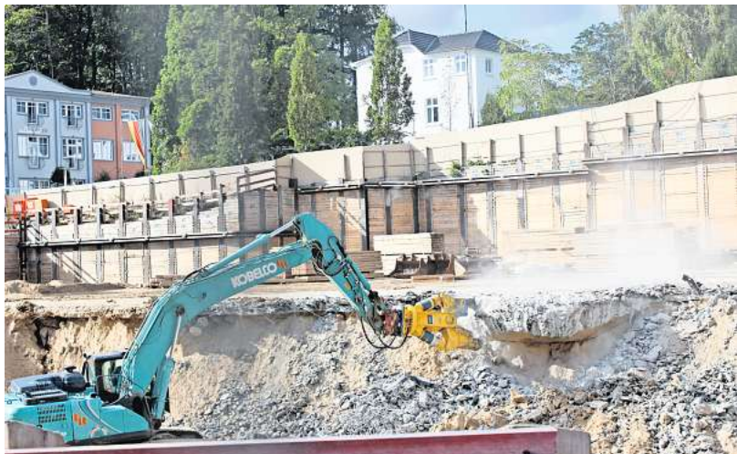
Die Betonbodenplatte des früheren Kurhauses wird Stück für Stück abgebrochen.
