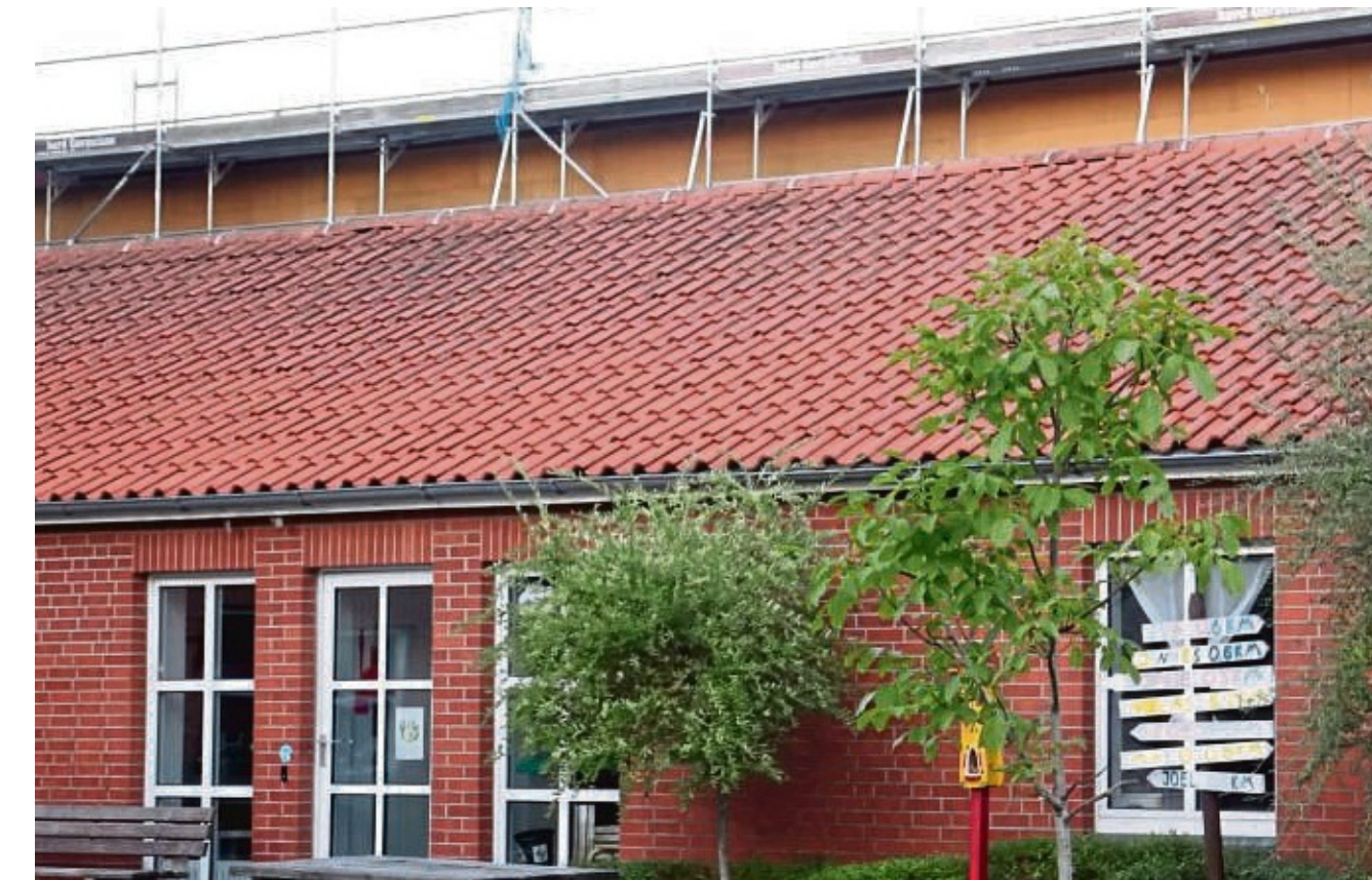
Die Turnhalle in Ehra wird saniert. Doch durch einen Wasserschaden steht die Gemeinde nun vor der Frage, ob der zuvor noch gut erhaltene Fußboden ausgetauscht werden muss.
