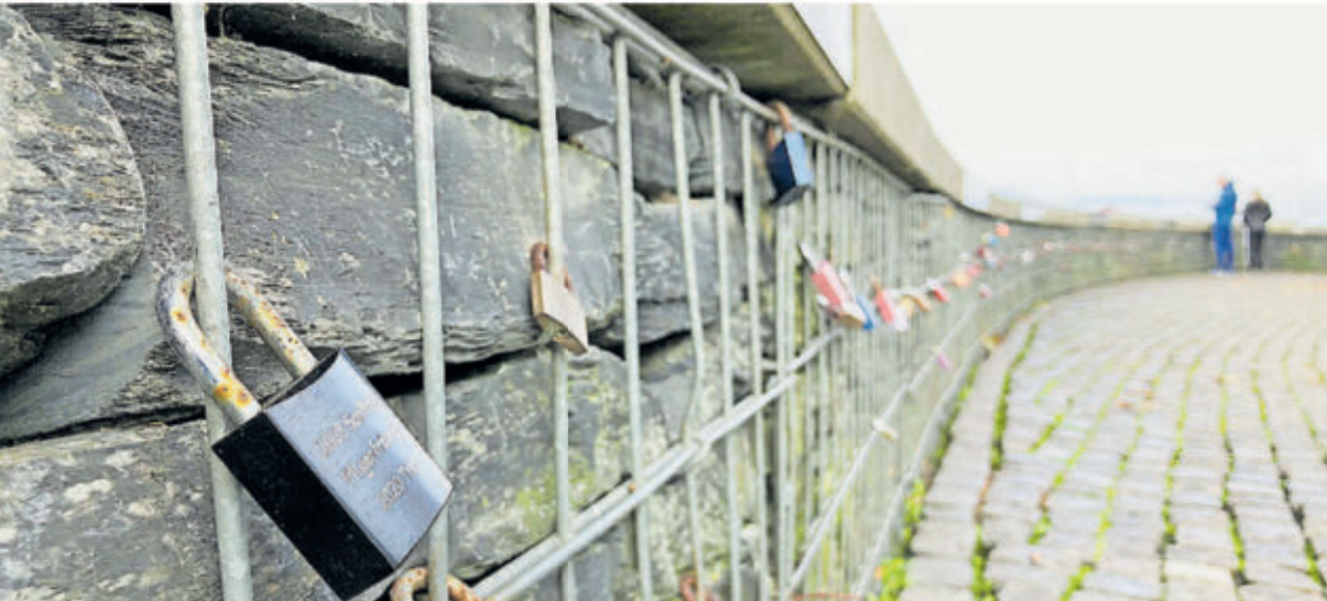
Die Stadt Trier toleriert Liebesschlösser an der sogenannten Knutschkurve in der Sickingenstraße.
