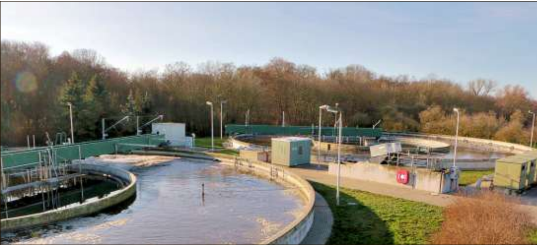
Eine kommunale Kläranlage, wie hier in der Börde, soll auch in Genthin entstehen.
