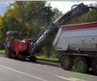
Auf der Ortsumfahrung Klietz wird die halbe Fahrbahn der Bundesstraße saniert. Foto: Ingo Freiherst
