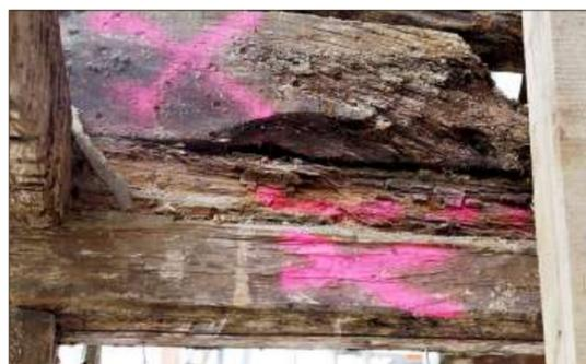
Rote Markierungen im Gebälk weisen auf schadhafte Holz hin, das noch bearbeitet werden muss.
