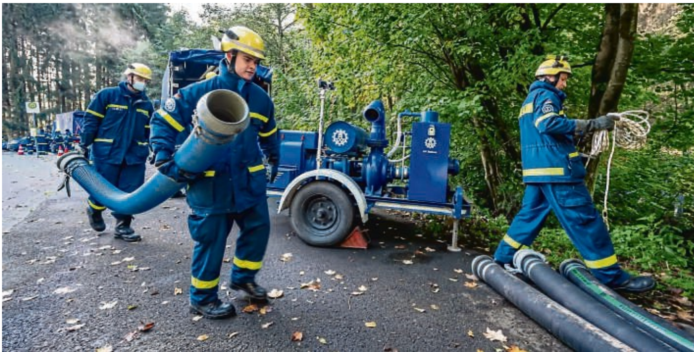
Lernziel der Übung des Halveraner THW auf Kiersper Gebiet war das Aufbauen einer Löschwasserversorgung für einen Waldbrand.
