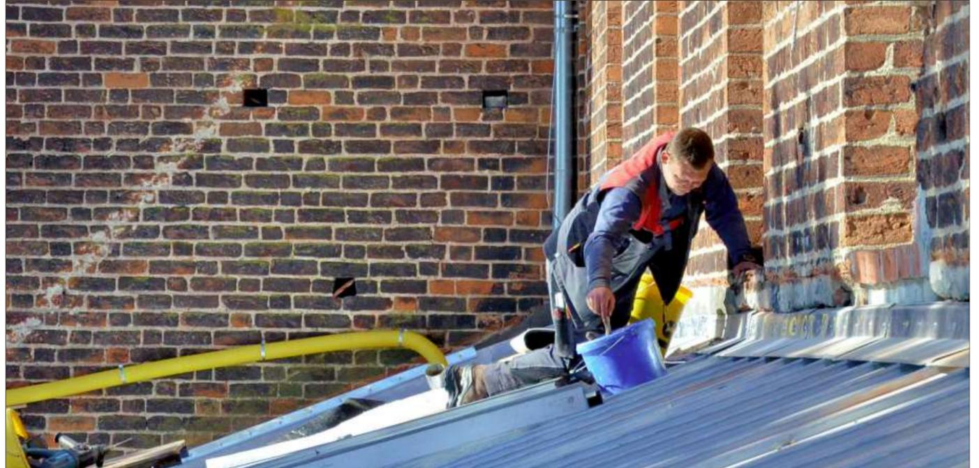
Dachdecker Marcus Gehrandt verputzt den Anschluss des neuen Daches an die Fassade des Hauptschiffes mit Mörtel. Dieser ist zwar faserverstärkt, dennoch werden irgendwann Spannungsrisse auftreten.
