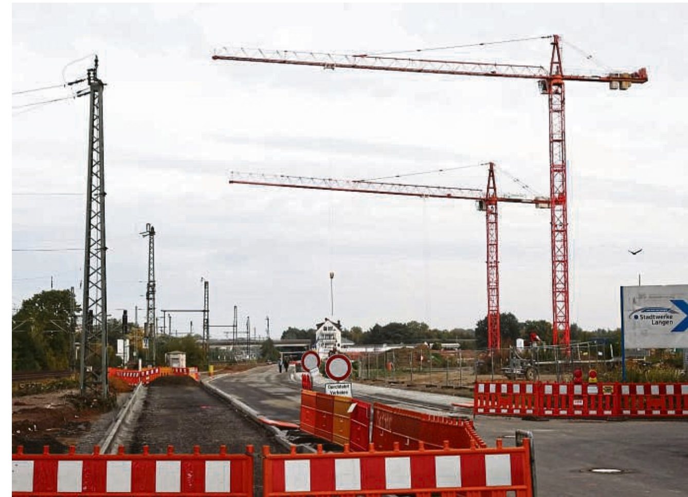
Noch fehlen die oberste Asphalttschicht, Lampenmasten, Markierungen und weitere Restarbeiten – aber nach aktuellem Stand wird die Liebigstraße im Dezember nach fast anderthalb Jahren wieder befahrbar sein.
