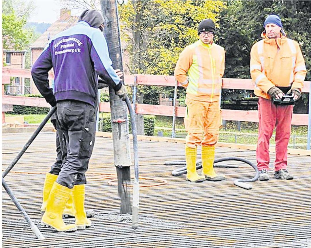
Am Freitag haben Arbeiter den zweiten Teilabschnitt zwischen dem Premnitzer Widerlager und dem Flusspfeiler betoniert und 40 bis 50 Tonnen Beton verarbeitet. FOTOS: WINFRID GANZER
