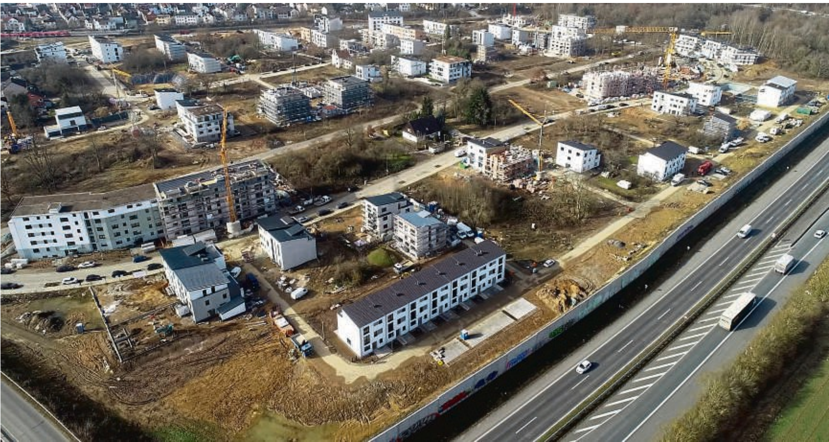
Das Baugebiet Bieber-Nord, hier eine Drohnen-Aufnahme vom Februar, wächst rasant. Jetzt starten die Arbeiten im sogenannten Grünzug und entlang der Lärmschutzwand. FOTO: GEORG-FOTO (B)
