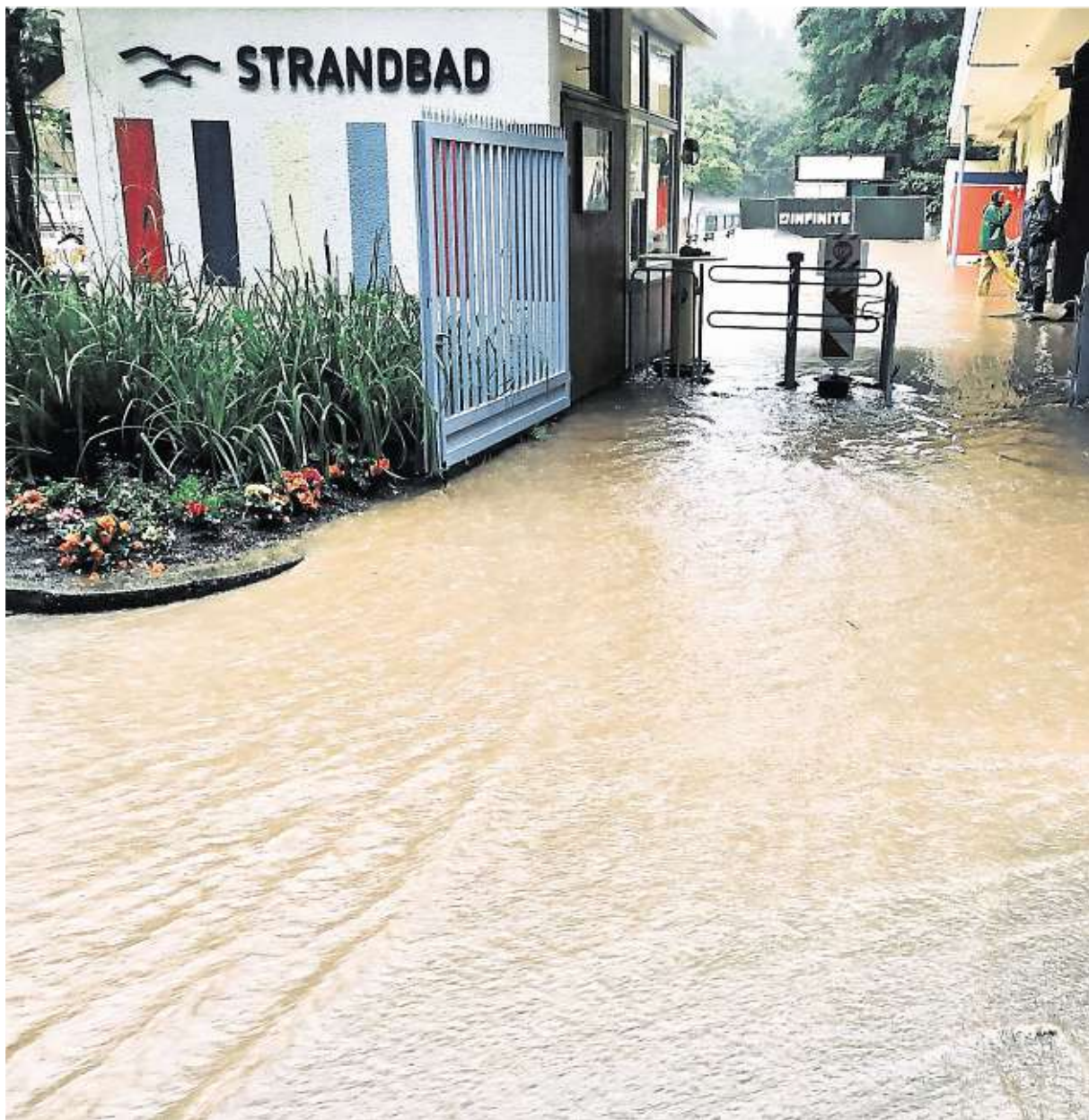
Bei dem Starkregen vom 14. Juli wurde das Freibad Dabringhausen von den Flutwellen aus der Linnefe überschwemmt. das Wasser stand teilweise bis zu 50 Zentimeter hoch.
