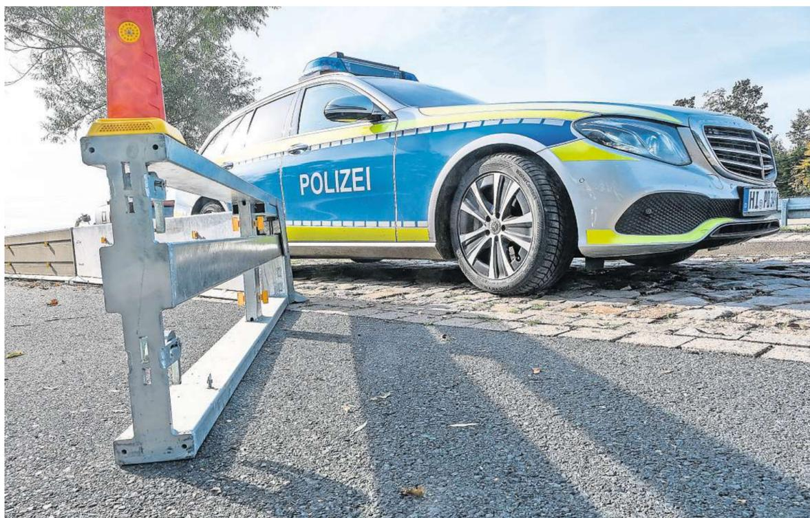
Metallteile wie diese gehören zu den Betonabgrenzungen der Mittelfahrbahn der A7. Diese Elemente lassen sich öffnen. FOTOS: CHRIS GOSSMANN
