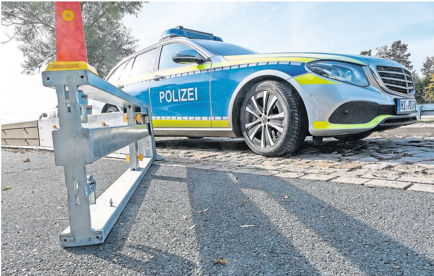
Metallteile wie diese gehören zu den Betonabgrenzungen der Mittelfahrbahn der A7. Diese Elemente lassen sich öffnen.
