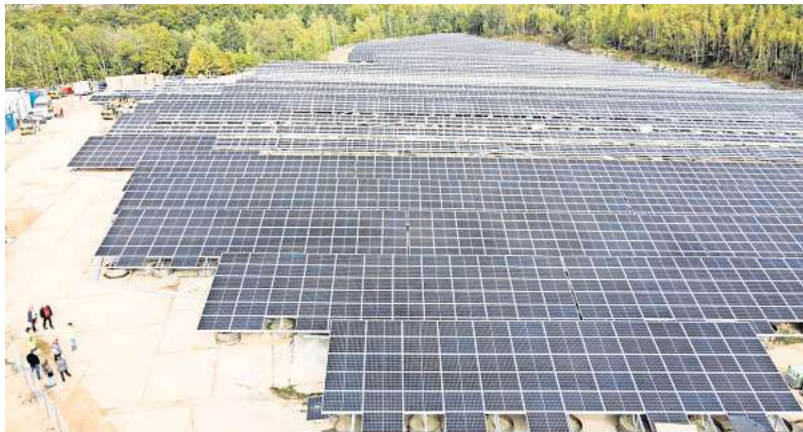
Die Firma Rapidsolar aus Eime errichtet diesen Solarpark bei Osterwald.
