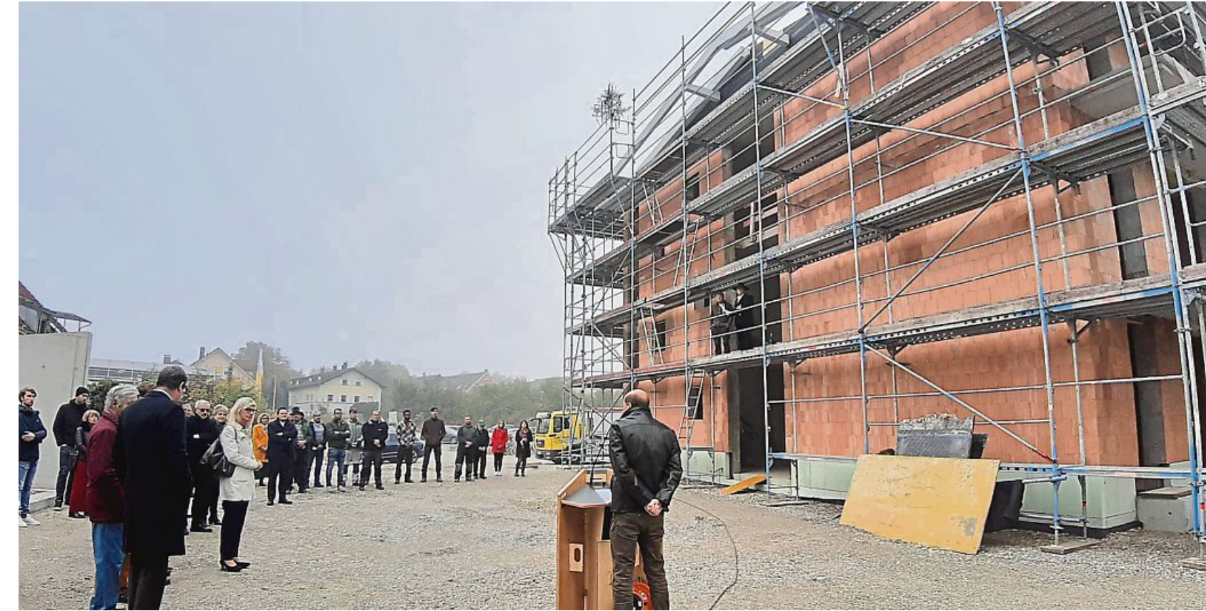
Das Dach ist drauf beim Betreuten Wohnen der Fischer’s Stiftung an der Haager Straße in Erding. Die 4,8-Millionen-Euro-Investition stellten am Montagvormittag Landrat Martin Bayerstorfer (l.) und Stiftungsgeschäftsführer Matthias Vögele (am Rednerpult) beim traditionellen Richtfest vor. Den Richtspruch verkündete Zimmerer Josef Mayer vom Gerüst aus.
