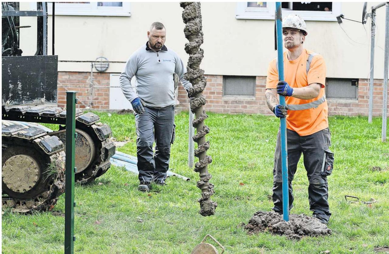
Die Sondierungsarbeiten mithilfe von Magnetsonden für die 80 Verdachtspunkte entlang der westlichen Leinenseite haben begonnen. Dieser Sondierungspunkt auf dem Wäscheplatz eines Innenhofes soll kommenden Mittwoch untersucht werden. Durch den Hof führt eine Gasleitung, sie muss abgeklemmt werden.
