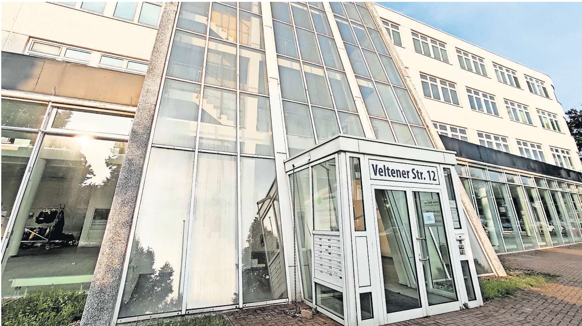
Das Haus in der Veltener Straße 12, Baujahr 1997, wird derzeit aufwendig saniert. Im Erdgeschoss wird es eine Art gläsernes Labor geben.
