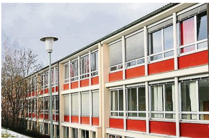
Der Nordtrakt der Volksschule Lochham wird für das Kurt-Huber-Gymnasium generalsaniert.
