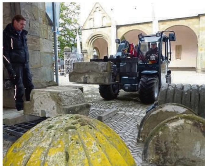
Die schweren Mauerkrone der Portal-Säulen zum Vorplatz der Basilika sind abgebaut. Sie werden aber erst später saniert.
