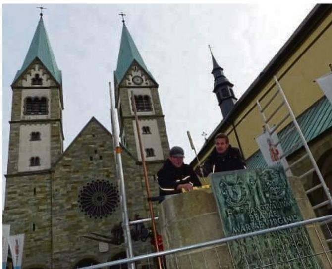
Ohne Zollstock und Wasserwaage geht's nicht: Oliver Preuß und Marcin Mokrezanski bei der Arbeit an den Säulen, die durchgehende Anker erhalten.
