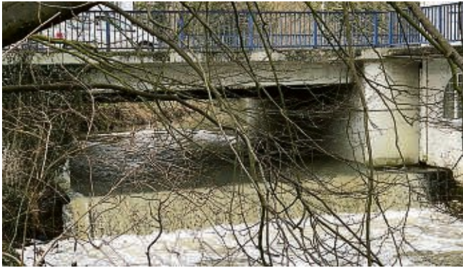
Das Wehr an der Hornemühle soll umgebaut werden.
