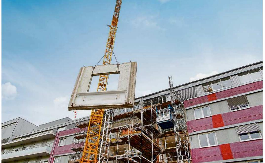
Die vorgehängte Betonfassade an der Südseite des Bettenhauses wird etappenweise entfernt, bevor eine neue Fassade errichtet werden kann. Fotos: St.-Antonius-Hospital/Ansgar Höing
