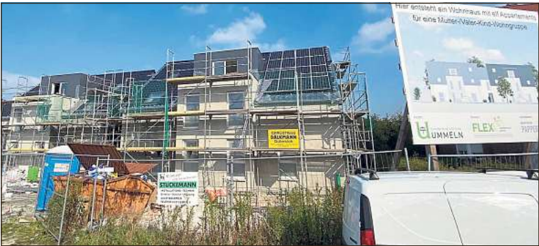
Nach dem Stillstand am Bau des Mutter-Kind-Hauses steht die Einrichtung jetzt kurz vor der Fertigstellung.
