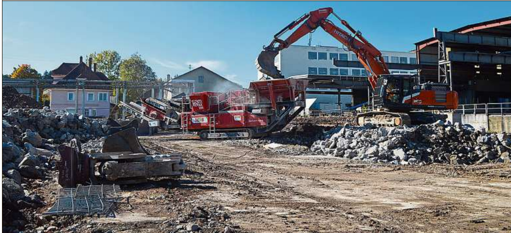
Das abgerissene Material wird noch vor Ort durch das Zusammenspiel der Maschinen der Abrissfirma BERB aufbereitet beziehungsweise zerkleinert.
