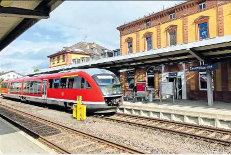
Wird um 21 Zentimeter höher: Von Mitte März bis September 2024 soll der „Hausbahnsteig“ direkt vorm Zweibrücker Bahnhofsgelände auf 76 Zentimeter angehoben werden. Die S-Bahn-Züge können dadurch barrierefrei bestiegen werden.
