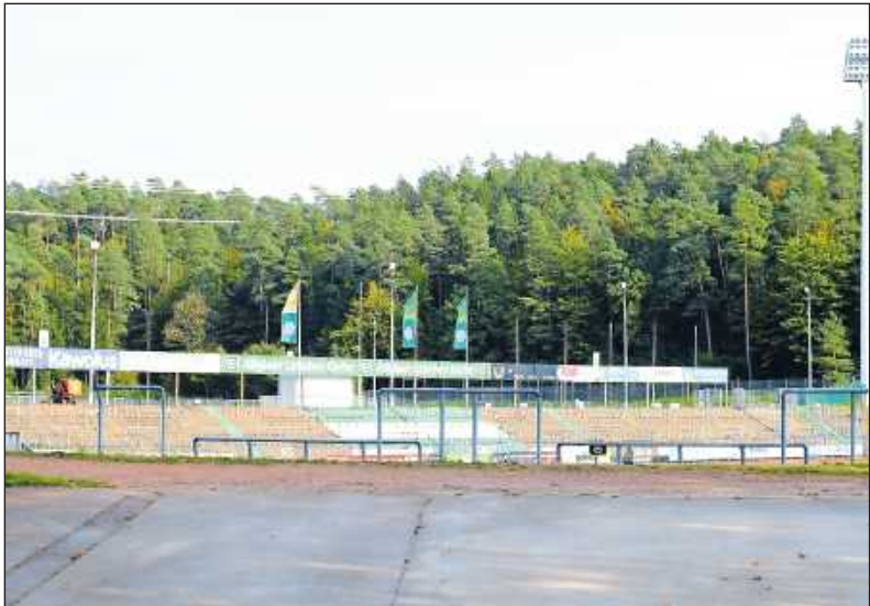
Die Gegengerade mit dem grünweiß gestrichenen FCH-Fanblock soll eine Überdachung erhalten.
