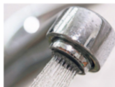
Wasser fließt aus einem Hahn: Der Stadtbetrieb sucht weiter nach der Quelle der Keime.
