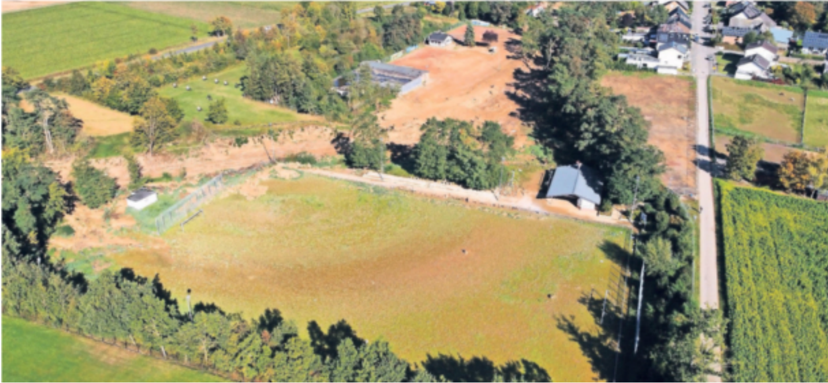
Zerstörte Sportstätten in den Orbachauen: Im Vordergrund befindet sich der Sportplatz, dahinter das Schützenhaus und der Tennisclub.
