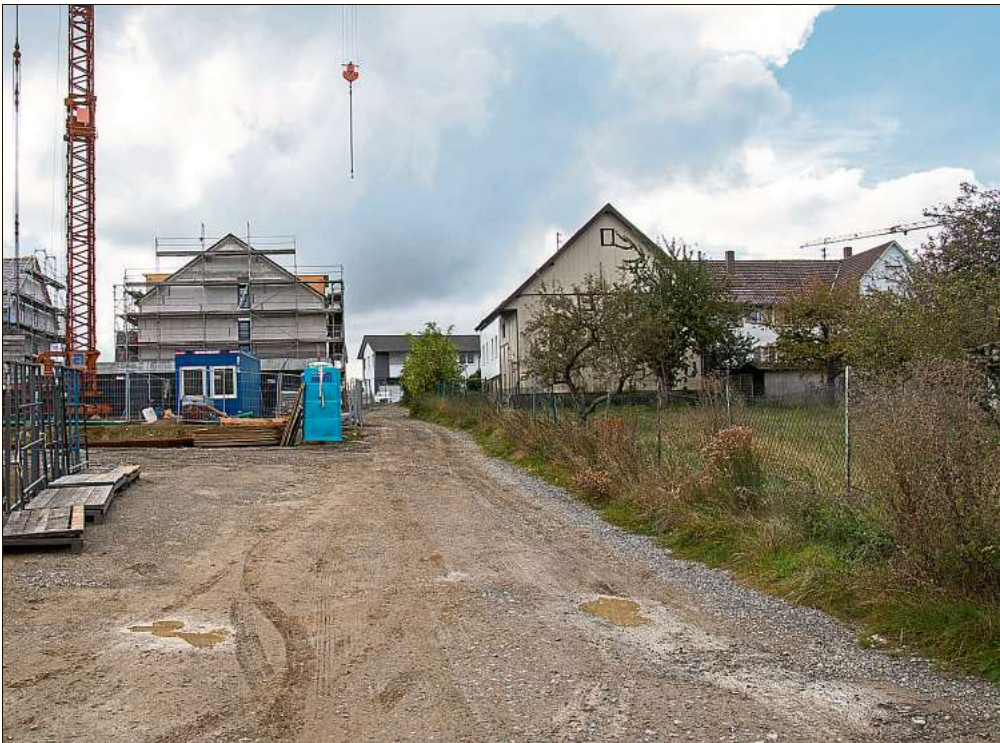
Noch führt nur eine Schotterpiste zu den Baustellen.
