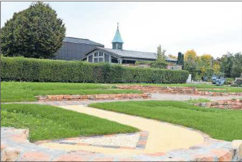
Die Anlage ist fertig, die Weinreben fehlen jedoch noch. FOTO: LINZMEIER-MEHN
