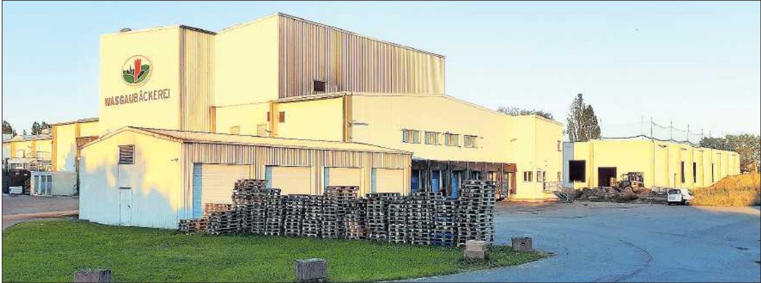
Die Wasgau-Großbäckerei in der Molkenbrunner Straße in Winzeln im Licht der Abendsonne. Ganz hinten: der Anbau, der Ende Januar 2022 in Betrieb gehen soll und in dem Konditorei-Produkte hergestellt werden sollen. FOTO: THIESSEN
