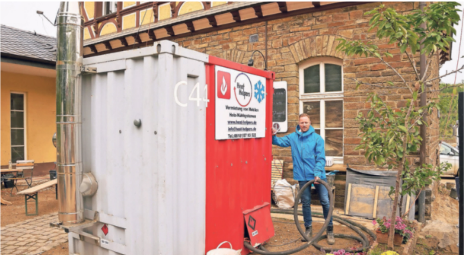
Thomas Laux, Mitglied des Krisenstabs aus Mayschoß, überprüft eines von vier mobilen Heizungssystemen im Ort, die 25 Haushalte versorgen.
