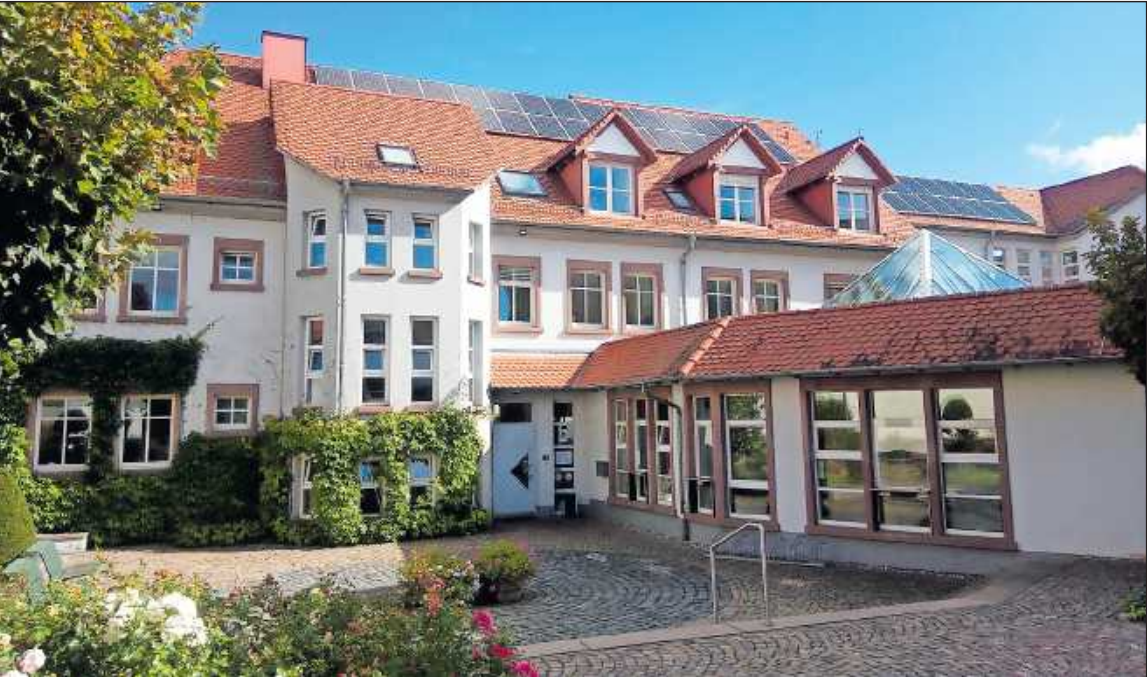
Das VG-Rathaus in Freinsheim mit der montierten Photovoltaikanlage. FOTO: VERWALTUNG/FREI
