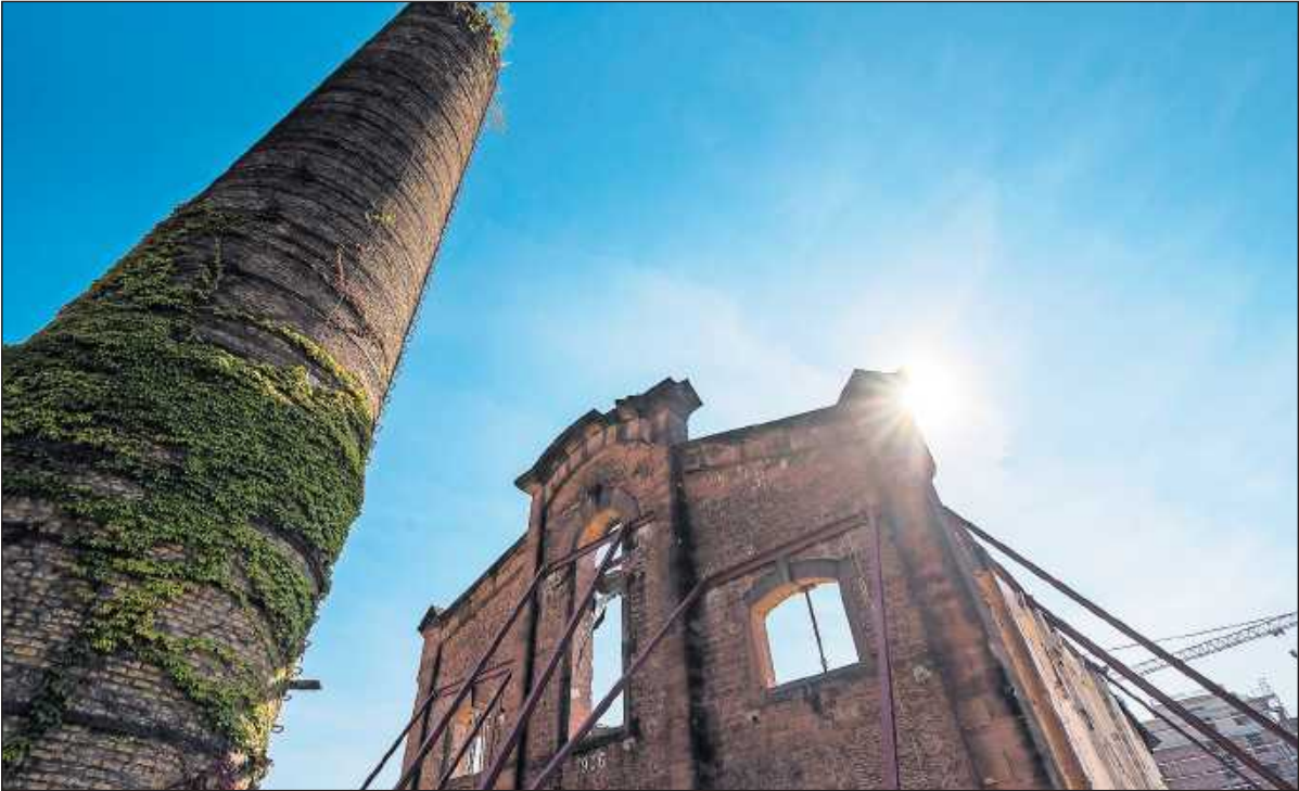
Das Neue Kesselhaus auf dem ehemaligen Pfaff-Gelände ist Teil des Projekts.
