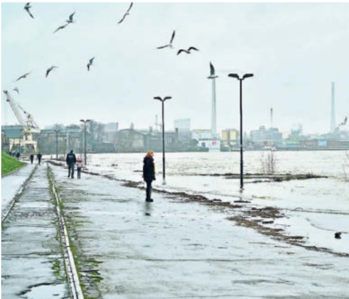
Das Untere Werft in Uerdingen gilt als Hochwasserrisikogebiet. Die Stadt plant dort wegen Rheinblick den Bau eines Hochufers. Archivfotos: A. Bischof
