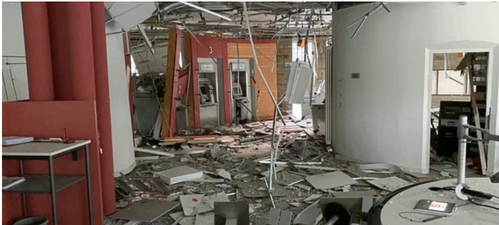
Nach der Sprengung war die Filiale ziemlich verwüstet.
