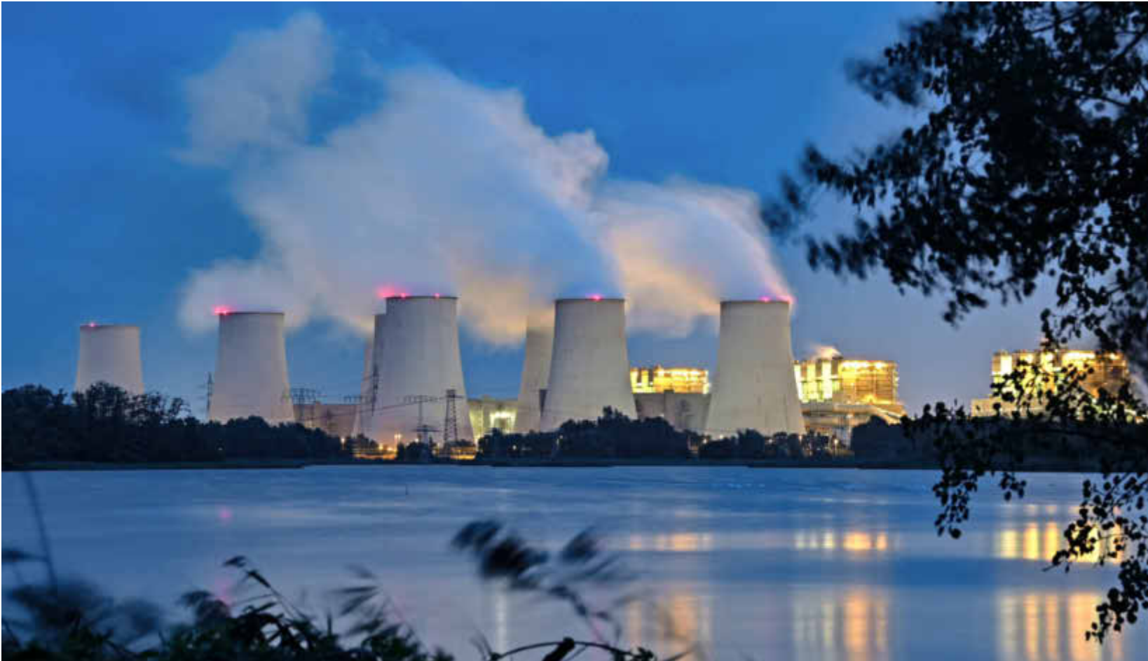
Das Braunkohlekraftwerk Jämschwalde in der Lausitz bei Cottbus ist eines der größten Europas. Spätestens 2038 soll auch dort Schluss sein.
