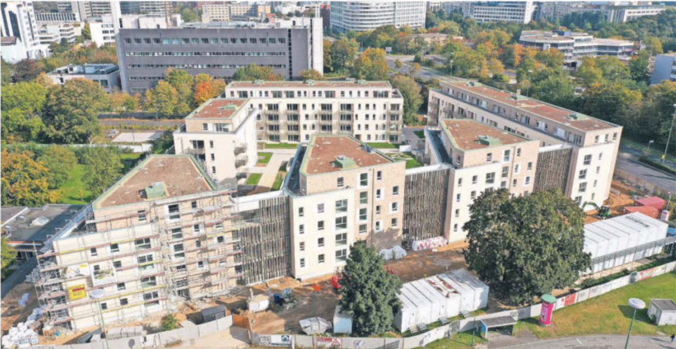
Auf dem früheren Leuchtenberg-Areal entsteht zurzeit ein Wohnquartier mit sechs Mehrfamilienhäusern und 154 Wohnungen.
