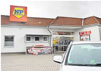
Nach Angaben von Edeka ist der NP-Markt an der Steinhauerstraße nicht mehr wirtschaftlich. Das Unternehmen favorisiert daher einen Neubau im Bereich Im Stiege.
