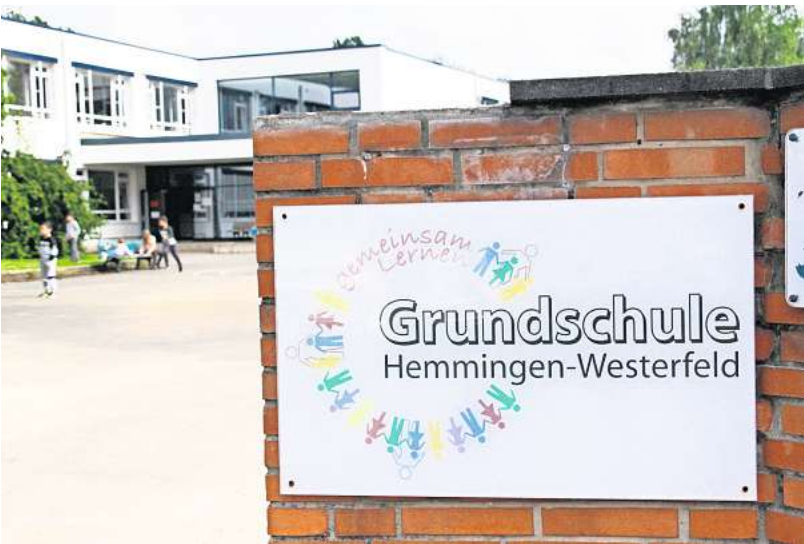
Die Sanierung des Außengeländes und der Digitalausbau an der Grundschule Hemmingen-Westerfeld sind nahezu abgeschlossen.
