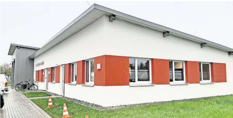
Etwa Mitte November kann die Feuerwehr in das neue Gebäude im Mühlenfeld umziehen.
