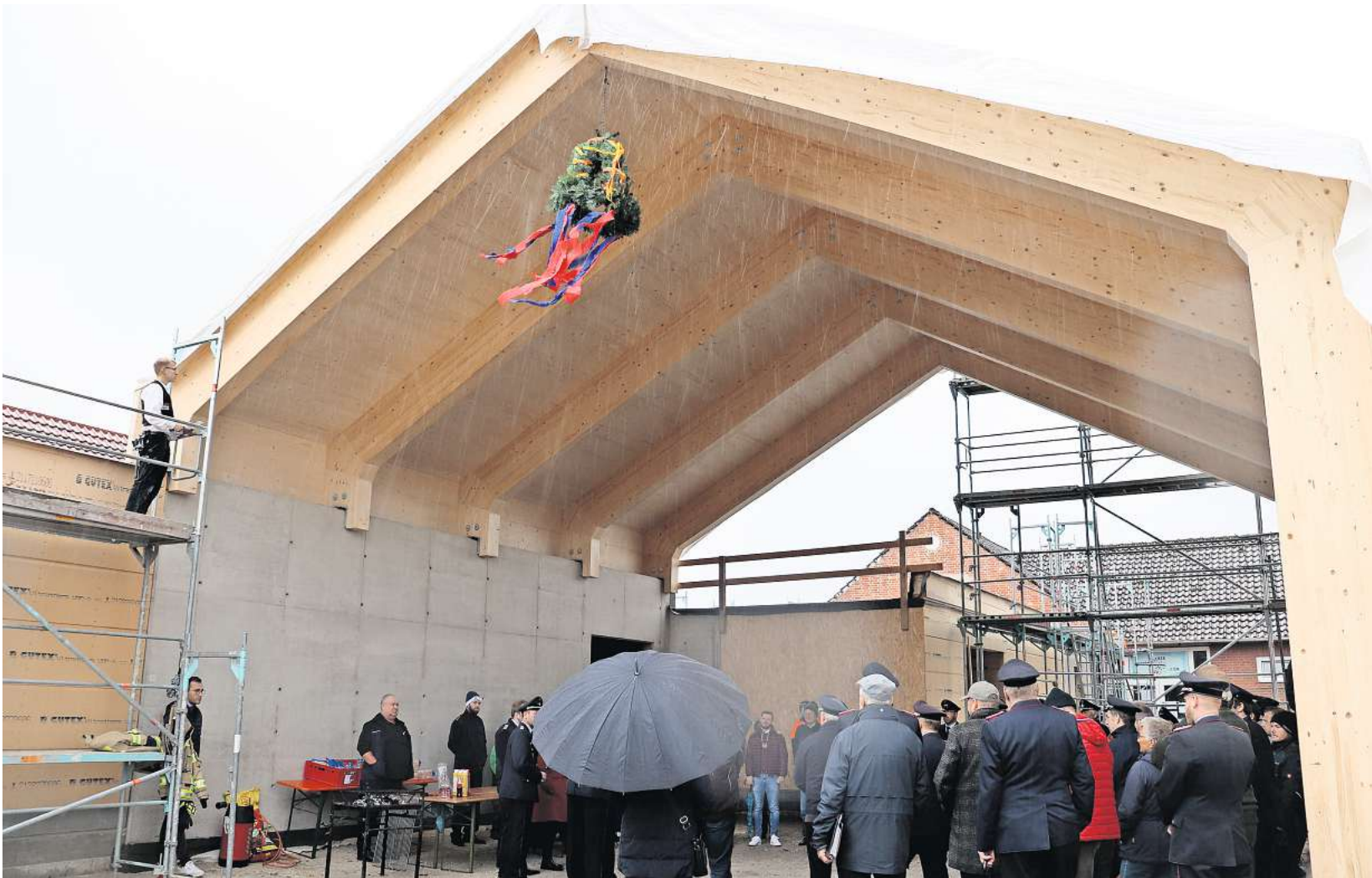
Das Dach ist dicht: Die Gäste suchen beim Richtfest für das neue Feuerwehrgerätehaus in Harkenbleck Schutz vor dem Regen.
