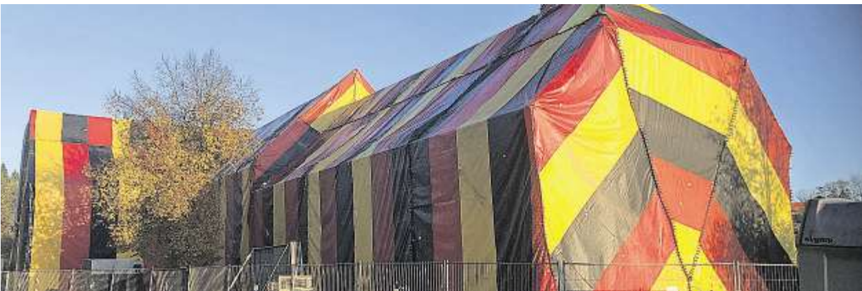
Komplett verhüllt ist die Spiegelglasschleife, denn das Gebäude muss begast werden.
