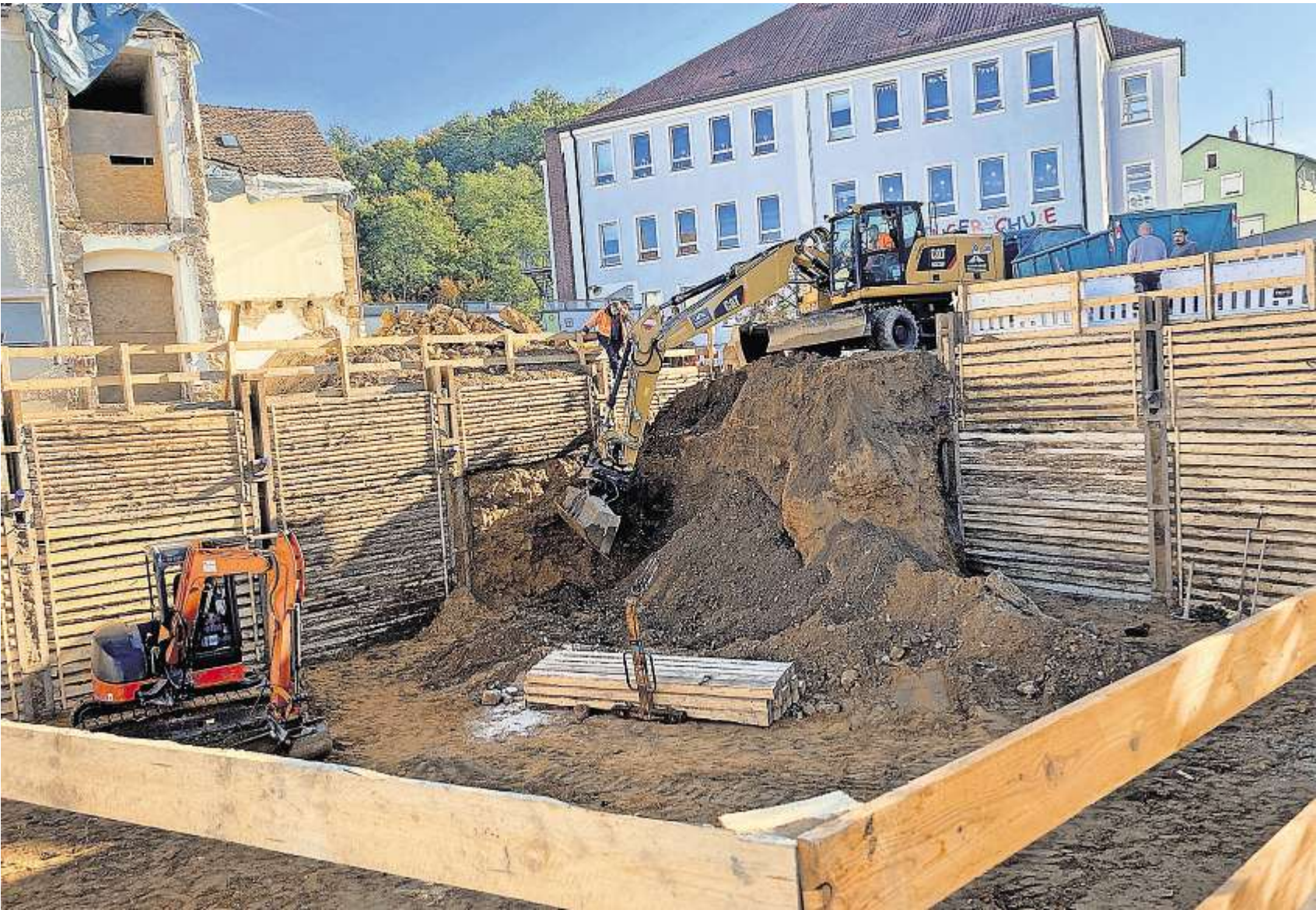
Rund drei Wochen lang wurde die Baugrube an der Gerhardingerschule auf archäologische Besonderheiten untersucht.
