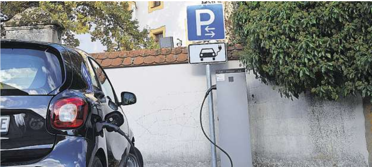
Die Nutzung der Ladestationen für Elektroautos wie hier beim Rathaus wird ab Januar 2022 in Schmidmühlen kostenpflichtig. FOTO: PAUL BÖHM
