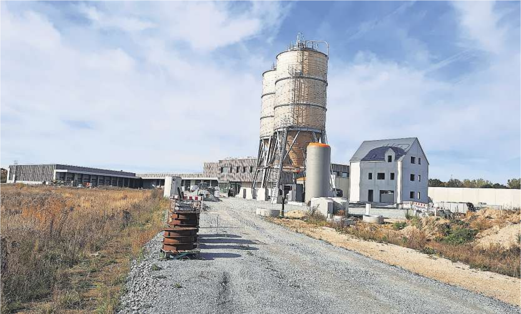
Der neue Kreisbauhof in Rosenhof liegt in den letzten Zügen. Es entstehen (von links nach rechts) zwei Hallen, das Verwaltungsgebäude (Mitte), zwei Streusilos und daneben die Sole-Anlage sowie das Simulationshaus für die Feuerwehren im Landkreis (ganz rechts).
