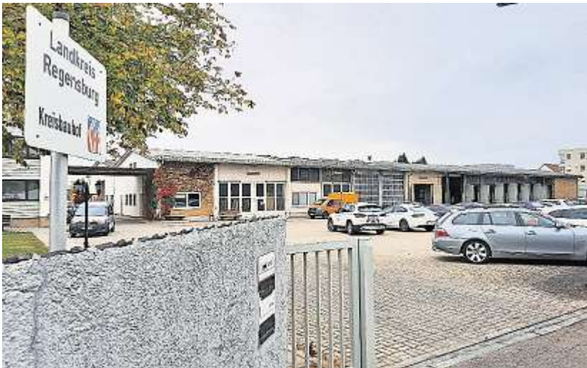
Der alte Kreisbauhof ist seit 1958 mitten in Neutraubling angesiedelt. Dort geht es beengt zu.
